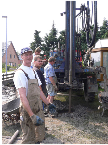
Heizung - Erdsonde: zwei Löcher im Garten
