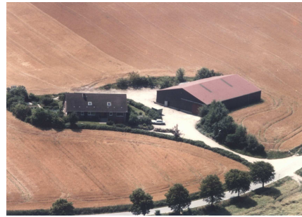
Heizung - Flächenkollektoren unter dem Rapsfeld
